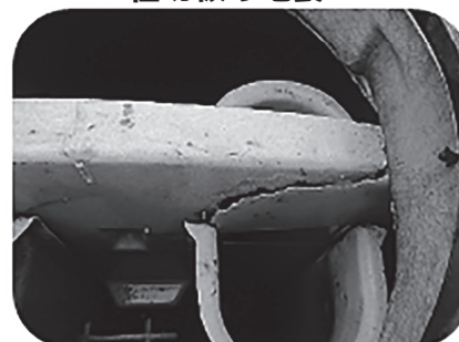
仕切板の亀裂
