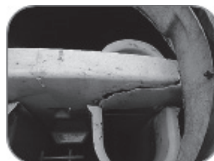
仕切板の亀裂
